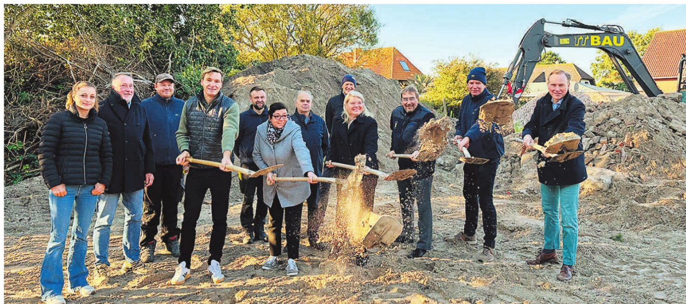
Bürgermeisterin Tina Mißmahl (Mitte), Landrat Sven Ambrosy, Kurdirektorin und Vertreter der Wohnungsbau Friesland sowie Architekt und Generalunternehmer beim symbolischen Spatenstich für das neue Mehrfamilienhaus an der Siedlerstraße auf Wangerooge.
